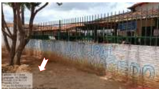
Figura 24 – Anexo – Desnível na entrada do sanitário.
