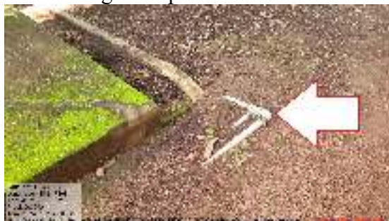
Figura 08 - Tubulações de esgoto sanitário em PVC rígido expostas.
