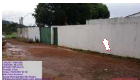
Figura 01 – Ausência de Identificação.
