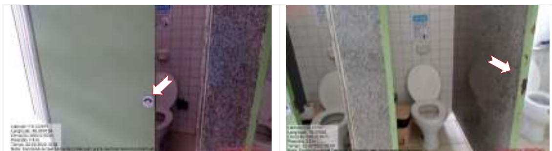
Figura 15 – Anexo – Caixa de descarga danificada.
