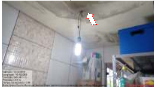
Figura 08 – Anexo - forro com manchas e indícios de infiltração.
