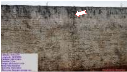
Figura 14 – Muro com fissuras e pintura ruim.
