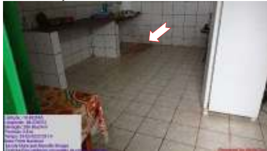
Figura 16 – Piso com fissuras e irregularidades.
