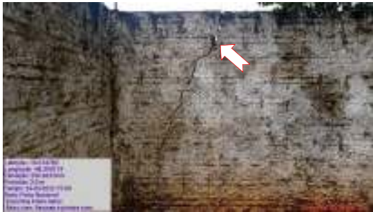
Figura 14 – Muro com fissuras e pintura ruim.
