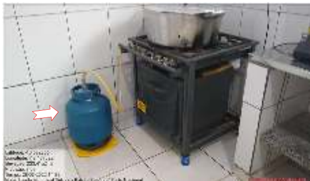
Figura 39- Botijão de gás acondicionado dentro da cozinha.
