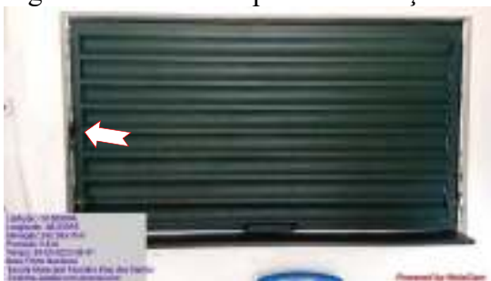
Figura 12 – Janela exposta a oxidação.
