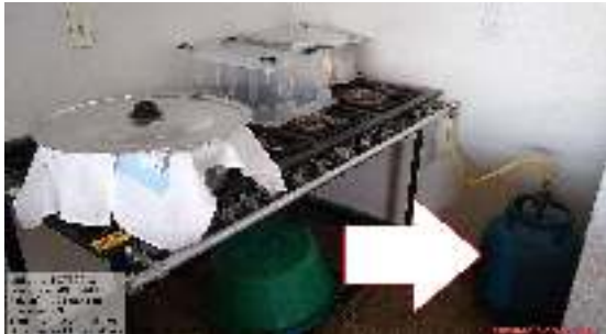
Figura 56 – Botijão de gás no interior da cozinha.
