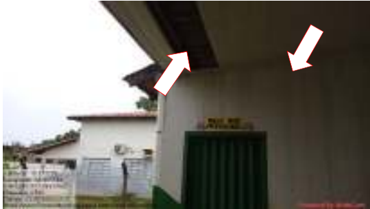
Figura 7 -Anexo - Forro trincado.
