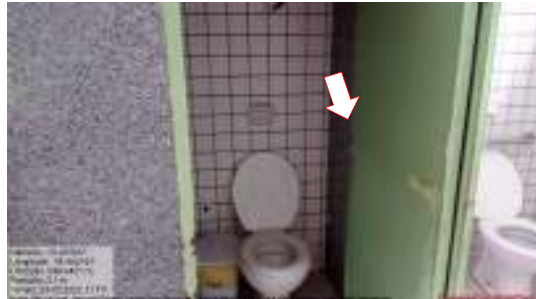
Figura 14 – Ausência de porta no sanitário PNE.
