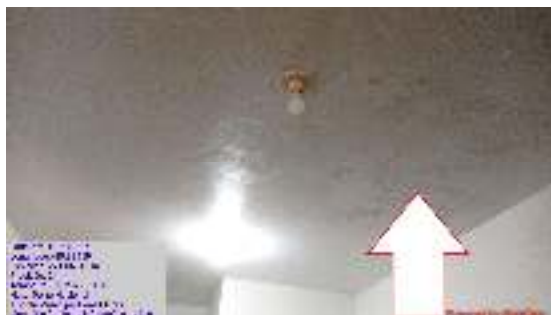
Figura 11 - Infiltrações na laje do banheiro feminino.
