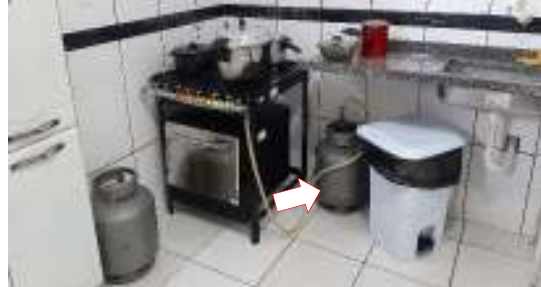
Figura 24 - Botijão de gás acondicionado dentro da cozinha. (anexo)
