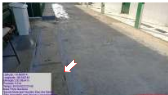
Figura 20 – Piso cerâmico com absorção d'água.
