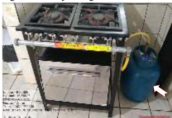
Figura 47- Botijão de gás acondicionado dentro da cozinha.
