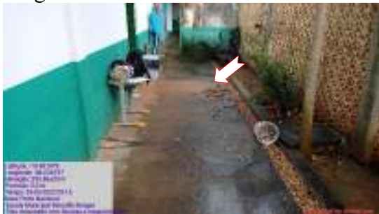
Figura 15 – Piso com fissuras e irregularidades.
