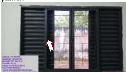
Figura 05 – Janela sem vidro e sem pintura.
