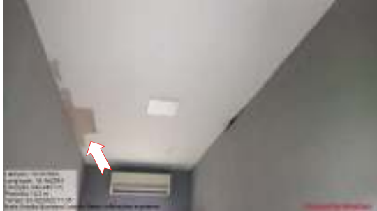
Figura 07 – Anexo - forro com goteira e infiltração.
