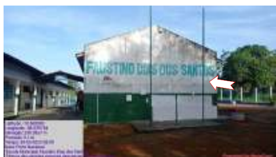
Figura 30 – Parede manchada.
