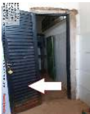
Figura 28 - Porta de acesso ao depósito no interior do banheiro feminino.
