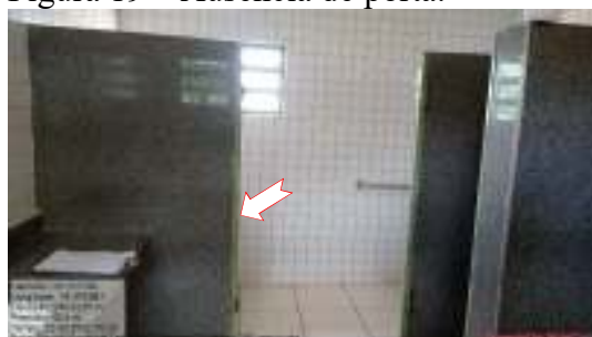
Figura 21 – Ausência de barra na porta do banheiro destinado a PNE.
