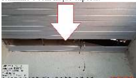
Figura 07 - Forro danificado no banheiro feminino e com fiação exposta.
