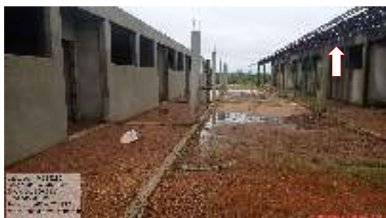
Figura 05 - Telhado oxidado.
