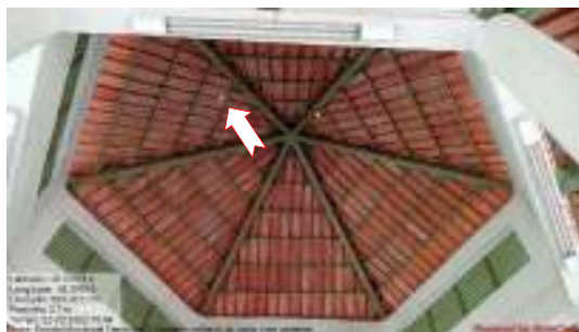
Figura 17 – Telhas quebradas.
