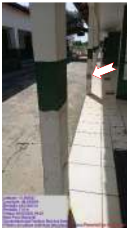
Figura 23 – Placa cerâmica descolada.
