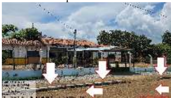
Figura 05 - Falta de vagas no estacionamento para idosos e PNEs.
