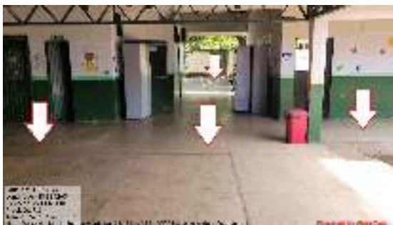
Figura 49 - Falta de piso tátil no acesso interno da escola.
