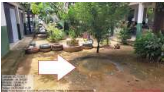
Figura 45 – Alagamento de águas pluviais no pátio descoberto da escola.
