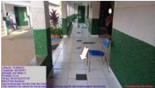
Figura 23 – Placa cerâmica descolada.
