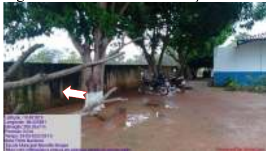
Figura 46 – Muro com infiltração.
