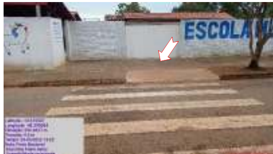
Figura 46 – Ausência de pisos tátil.
