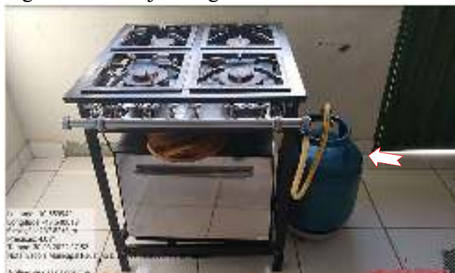
Figura 55 – Botijão de gás acondicionado dentro da cozinha.
