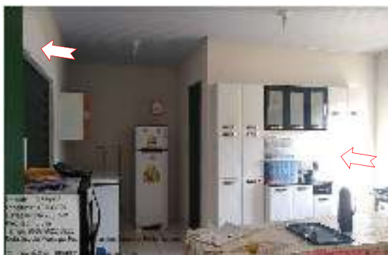
Figura 58 – Paredes da cozinha sem acabamento liso, impermeável e lavável.
