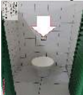
Figura 12 - Vazamento nas instalações do lavatório.
