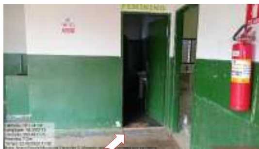
Figura 23 – Anexo - Desnível na entrada do sanitário.
