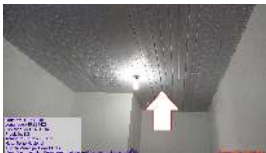
Figura 08 - Forro com deformação no banheiro masculino.
