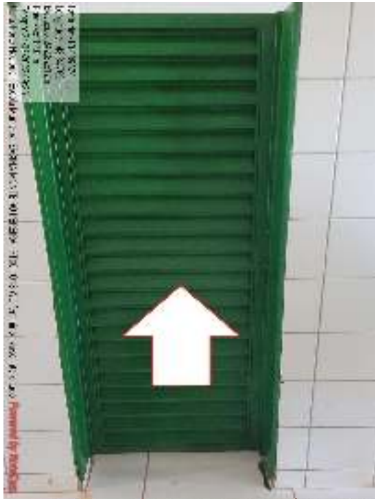
Figura 11 - Vaso sanitário interditado por falta de funcionamento.
