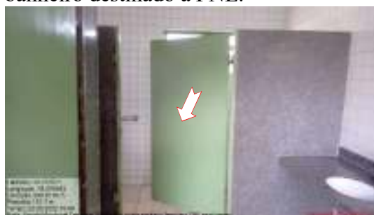
Figura 23 – Anexo - Desnível na entrada do sanitário.
