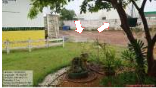
Figura 18 – Acúmulo de água no terreno e pintura do muro manchada.
