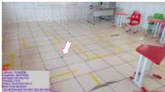
Figura 19 – Piso cerâmico com placas quebradas.
