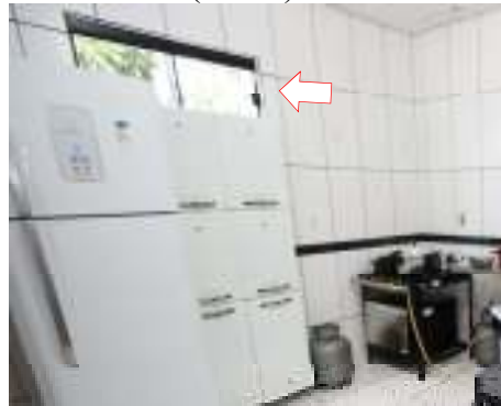
Figura 26- Janela da cozinha sem tela milimétrica. (anexo)
