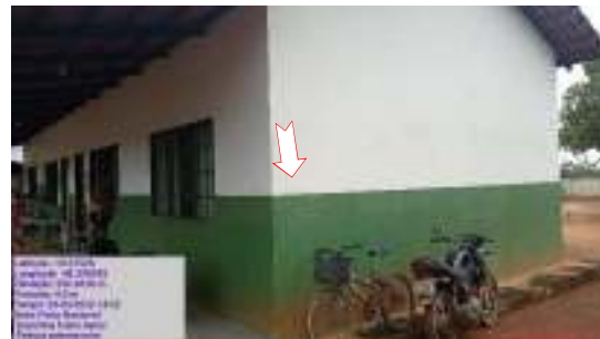
Figura 18 – Pintura desgastada e manchada.
