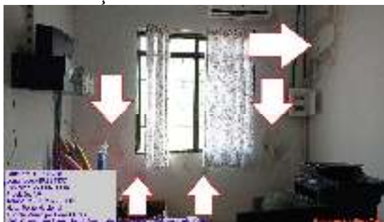
Figura 14 - Infiltrações nas paredes da sala dos Professores / Coordenação.
