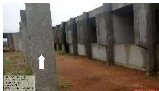
Figura 06 - Ausência de contrapiso.
