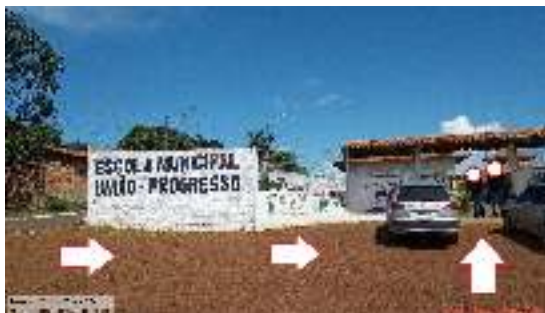
Figura 04 - Falta calçada cimentada com instalação de piso tátil no acesso frontal da escola.
