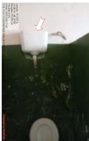
Figura 15 – Anexo – Caixa de descarga danificada.
