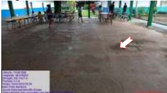
Figura 15 – Piso com fissuras e irregularidades.
