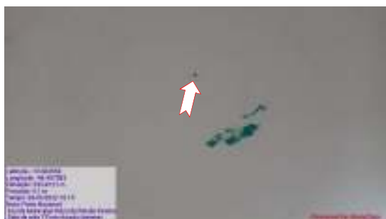
Figura 29 – Forro com indícios de infiltração.
