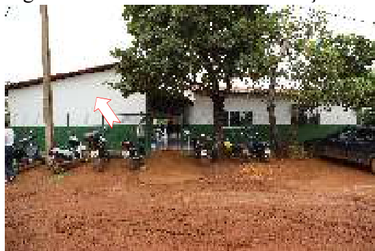
Figura 01 – Ausência de Identificação.
