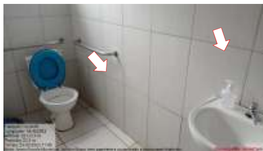
Figura 16 – Anexo - Vaso sanitário PNE sem papeleira, porta sabão e porta papel higiênico.
