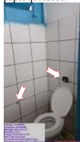
Figura 37 – Ausência de espelho, cerâmicas quebradas, inadequada instalação dos chuveiros.
