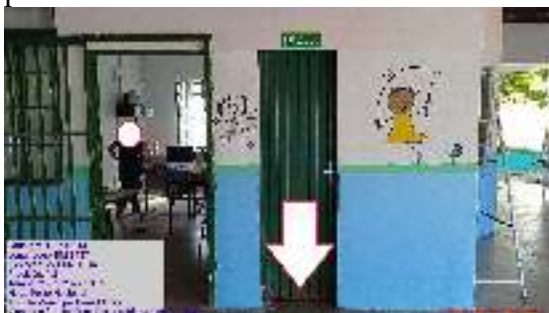
Figura 23 - Porta metálica da sala de aula com oxidação (ferrugem), fechadura quebrada e pintura ruim.
