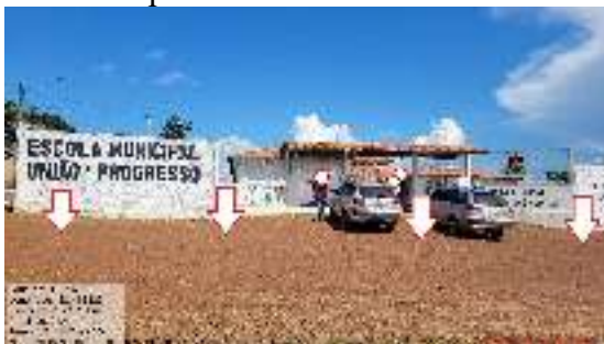
Figura 03 - Faltam vagas exclusivas e sinalizadas no estacionamento frontal destinado para os idosos e PNEs.
