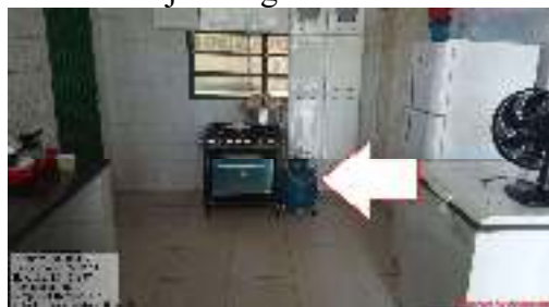
Figura 14 – Botijão de gás no interior da cozinha.
