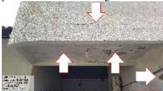
Figura 11 - Infiltrações na laje do banheiro feminino.
