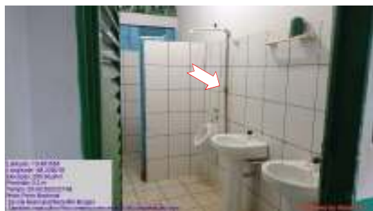
Figura 36 – Ausência de espelho, cerâmica ruim, inadequada instalação dos chuveiros.
