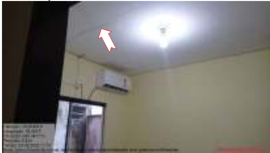
Figura 07 – Anexo - forro com goteira e infiltração.
