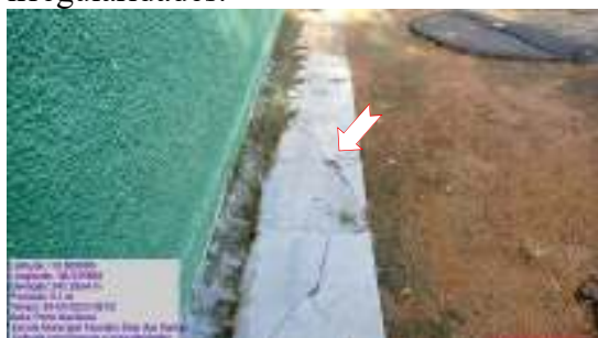
Figura 19 – Piso cerâmico com placas quebradas.
