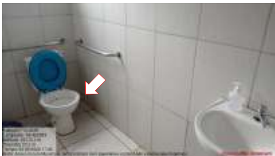
Figura 21 – Anexo - Vaso sanitário comum em banheiro destinado a PNE.
