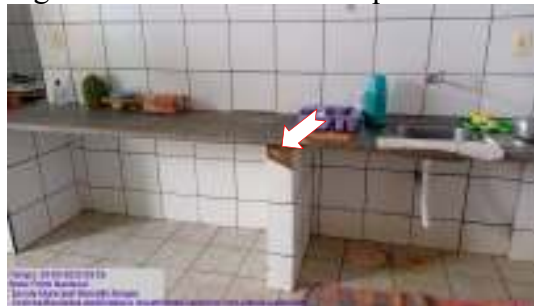
Figura 26 – Placa cerâmica quebrada.
