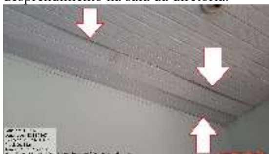
Figura 07 - Forro danificado no banheiro feminino e com fiação exposta.
