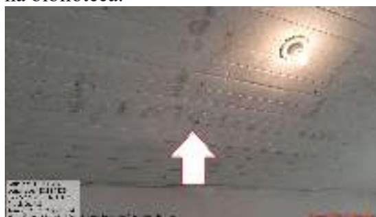
Figura 08 - Forro com deformação no banheiro masculino.
