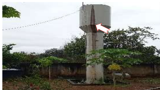
Figura 11 – Caixa d'água oxidada.
