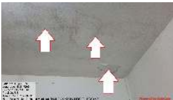
Figura 03 - Infiltrações na laje da sala de aula.
