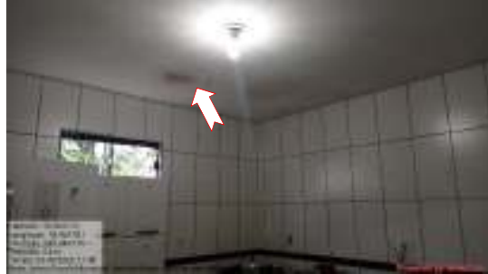
Figura 08 – Anexo - forro com manchas e indícios de infiltração.
