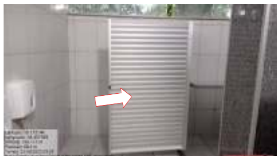
Figura 13 – Ausência de piso tátil.
