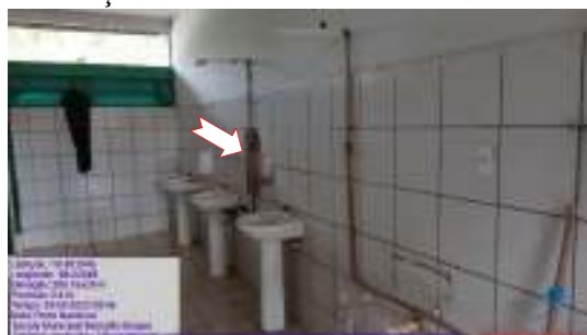
Figura 37 – Ausência de espelho, cerâmicas quebradas, inadequada instalação dos chuveiros.
