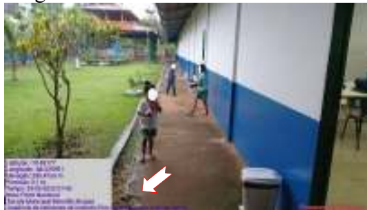
Figura 16 – Piso com fissuras e irregularidades.
