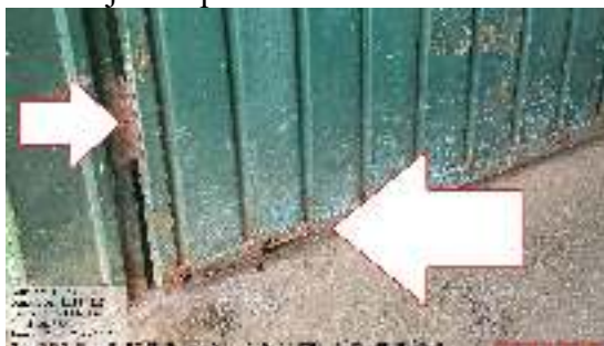
Figura 24 - Porta metálica da sala de aula com oxidação (ferrugem), fechadura quebrada e pintura ruim.
