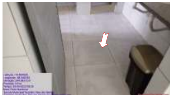
Figura 20 – Piso cerâmico com absorção d'água.
