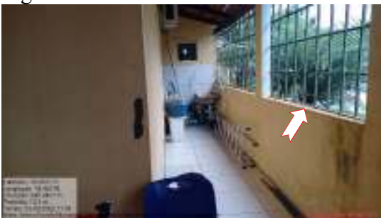
Figura 04 – Grades oxidadas.
