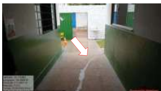
Figura 13 – Ausência de piso tátil.
