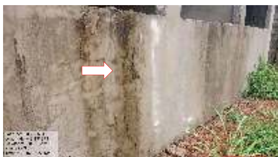
Figura 07 - Infiltração no reboco.
