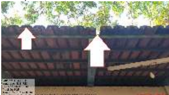
Figura 03 - Infiltrações na laje da sala de aula.
