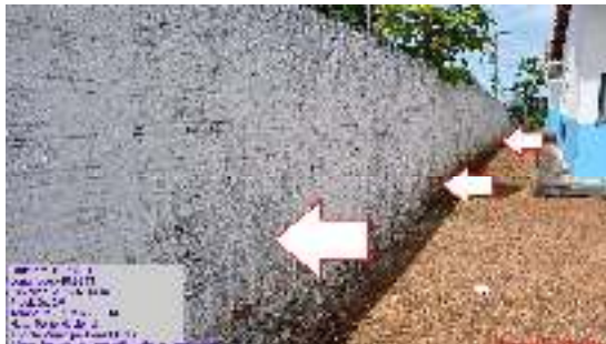
Figura 12 - Infiltrações nas paredes da sala de Orientação Educacional/Secretaria.
