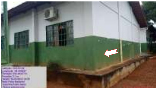
Figura 17 – Pintura desgastada e manchada.
