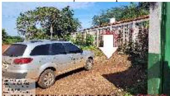
Figura 30 - Falta vaga sinalizada para idoso e PNE e calçadas com piso tátil.
