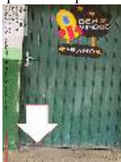
Figura 24 - Porta metálica da sala de aula com oxidação (ferrugem), fechadura quebrada e pintura ruim.
