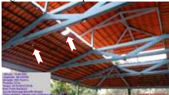
Figura 41 – Telhas quebradas.
