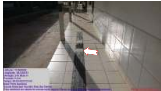
Figura 24 – Placa cerâmica descolada.
