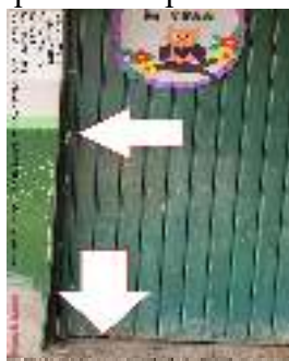
Figura 23 - Porta metálica da sala de aula com oxidação (ferrugem), fechadura quebrada e pintura ruim.
