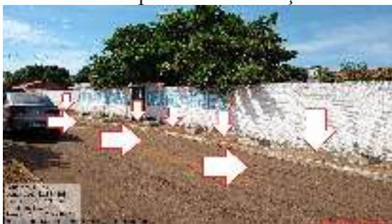
Figura 49 - Falta de piso tátil no acesso interno da escola.
