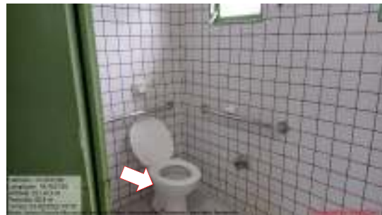
Figura 20 – Vaso sanitário comum em banheiro destinado a PNE.
