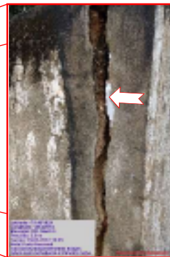
Figura 46 – Muro com infiltração.
