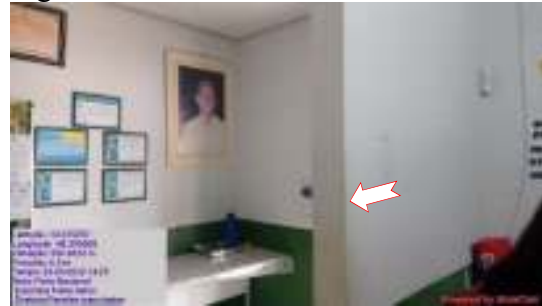
Figura 18 – Pintura desgastada e manchada.
