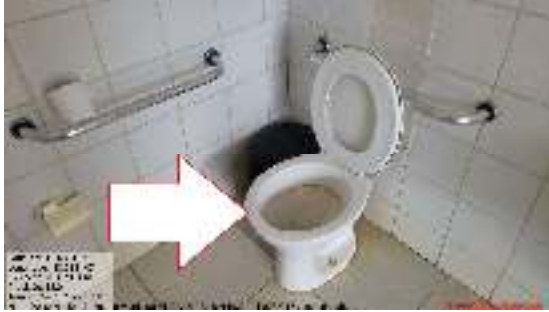
Figura 12 - Vaso sanitário inadequado às normas de acessibilidade.
