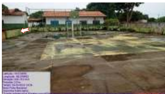
Figura 37 – Pintura desgastada.
