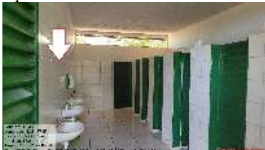
Figura 27 - Banheiro feminino sem espelho.
