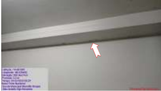
Figura 43 – Viga fissurada.
