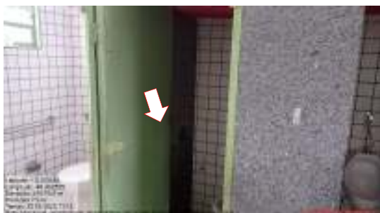
Figura 15 – Porta sem fechadura e pintura ruim.
