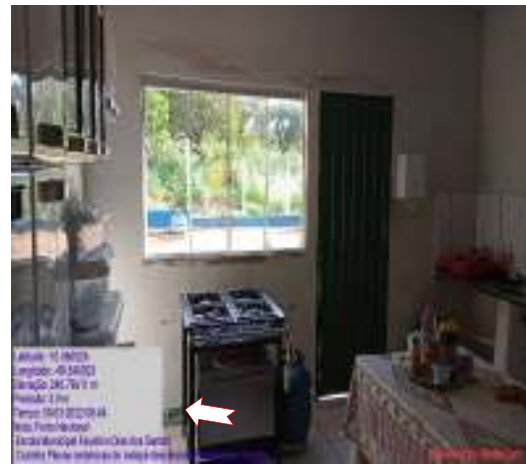
Figura 24 – Placa cerâmica descolada.
