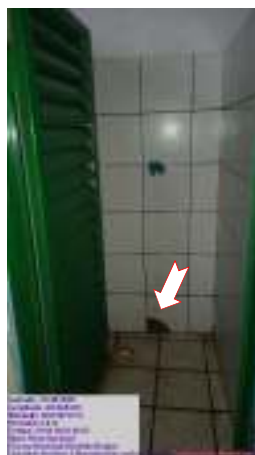
Figura 37 – Ausência de espelho, cerâmicas quebradas, inadequada instalação dos chuveiros.
