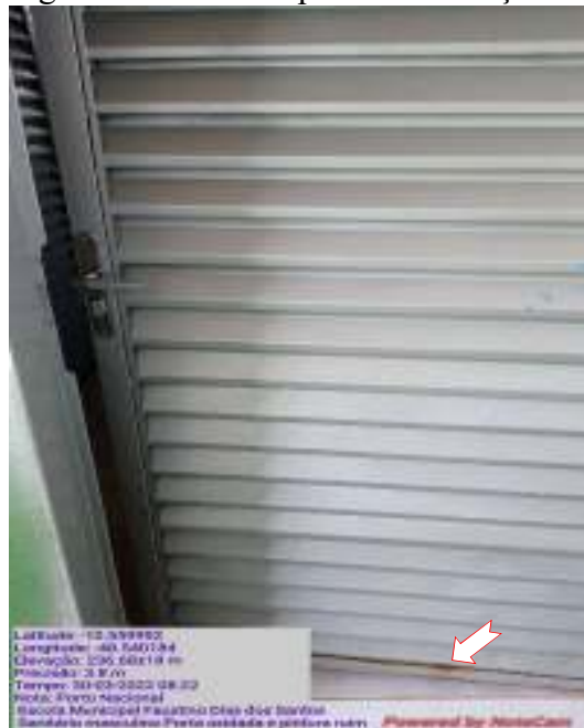
Figura 11 – Porta expostas a oxidação.
