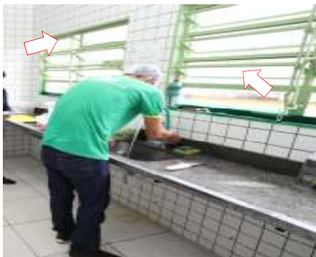
Figura 25-Janela da cozinha sem tela milimétrica. (sede)
