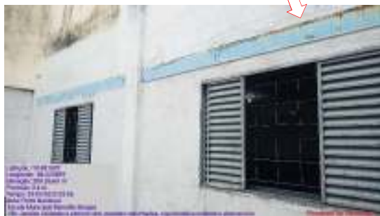
Figura 10 – Viga metálica e Janela oxidada.
