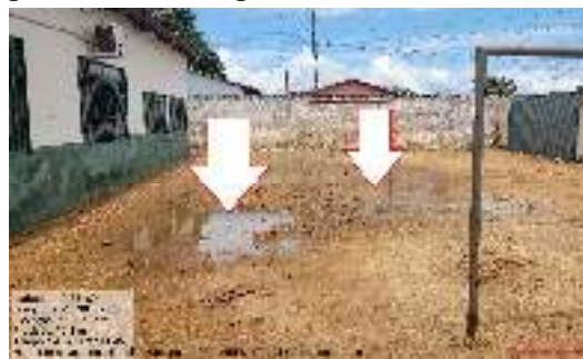
Figura 46 – Alagamento de águas pluviais no campo de futebol da escola.
