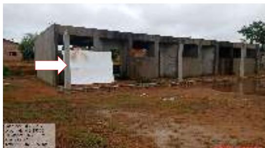
Figura 03 - Ausência de telhado.
